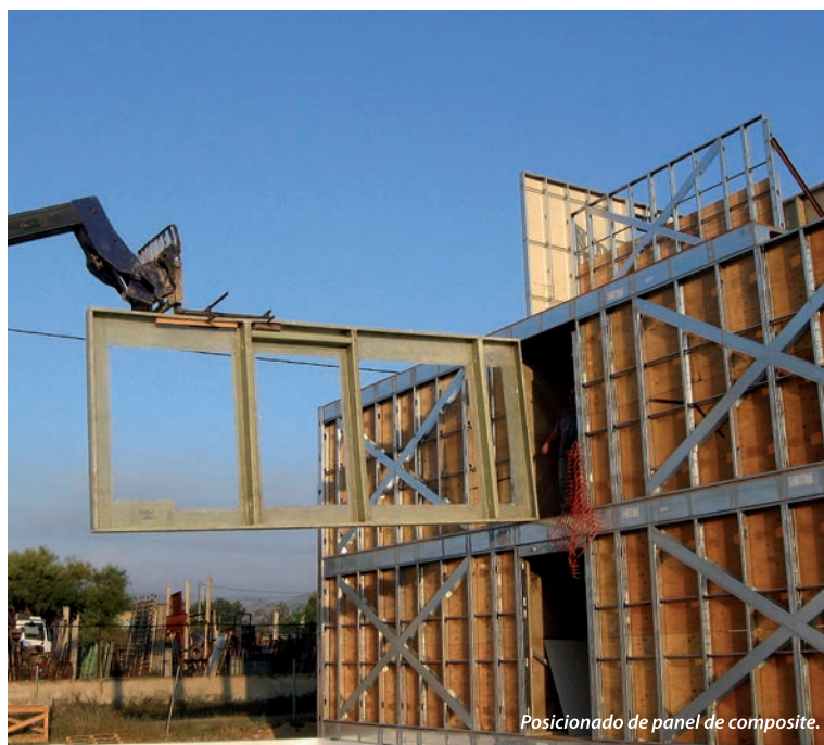
Posicionado de panel en vertical.
